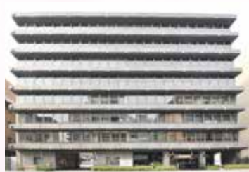
武田病院健診センター
